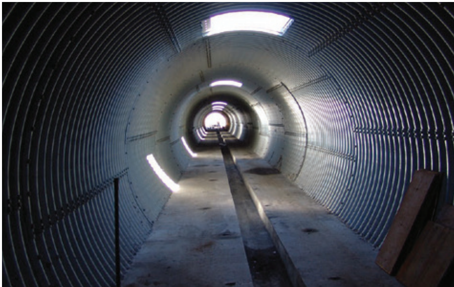
MULTI PLATE - TÚNEL DE RECUPERACIÓN
