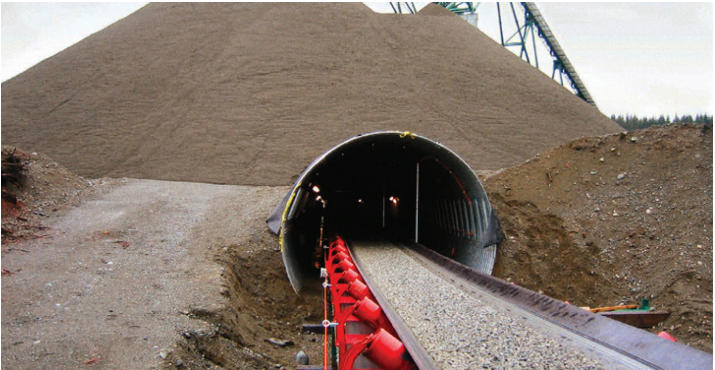
MULTI PLATE - TÚNEL DE RECUPERACIÓN
