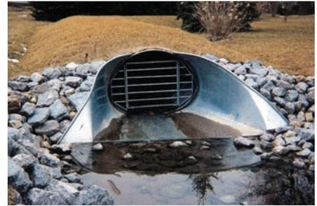
TABLIERS DE PONCEAU DE TUYAU EN TÔLE D'ACIER AVEC GRILLE FONCTIONNELLE
