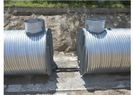
SYSTÈME DE RÉSERVOIRS D'EAU PLUVIALES EN TTO GALVANISÉ
