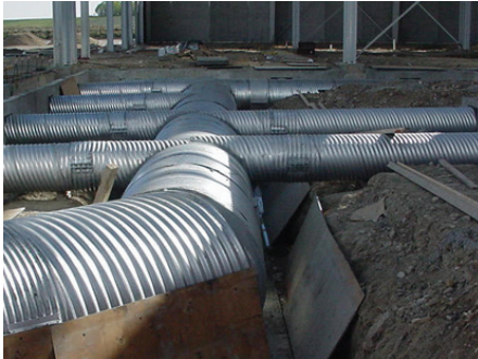
IL EST POSSIBLE DE FABRIQUER DES TTO ADAPTÉS À UNE MULTITUDE DE CONFIGURATIONS
