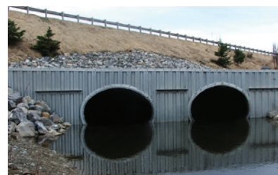
MURS DE TÊTE / PARAFOUILLE EN PALPLANCHES
