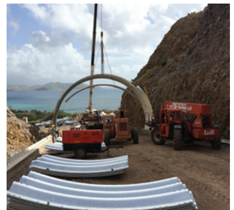
SAINT-KITTS - LES COMPOSANTS SONT LIVRÉS EN PAQUETS EMBOÎTÉS POUR UN TRANSPORT ÉCONOMIQUE
