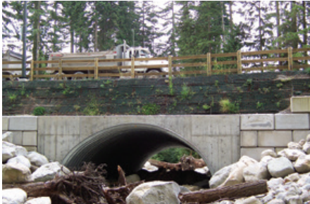
MUR DE TÊTE COULÉ SUR PLACE AVEC MURS EN AILE À BLOCS SEGMENTAIRES
