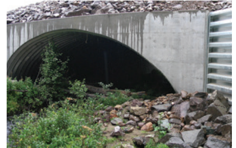
MURS DE TÊTE EN BÉTON COULÉ SUR PLACE AVEC MURS-CAISSONS ARMTEC
