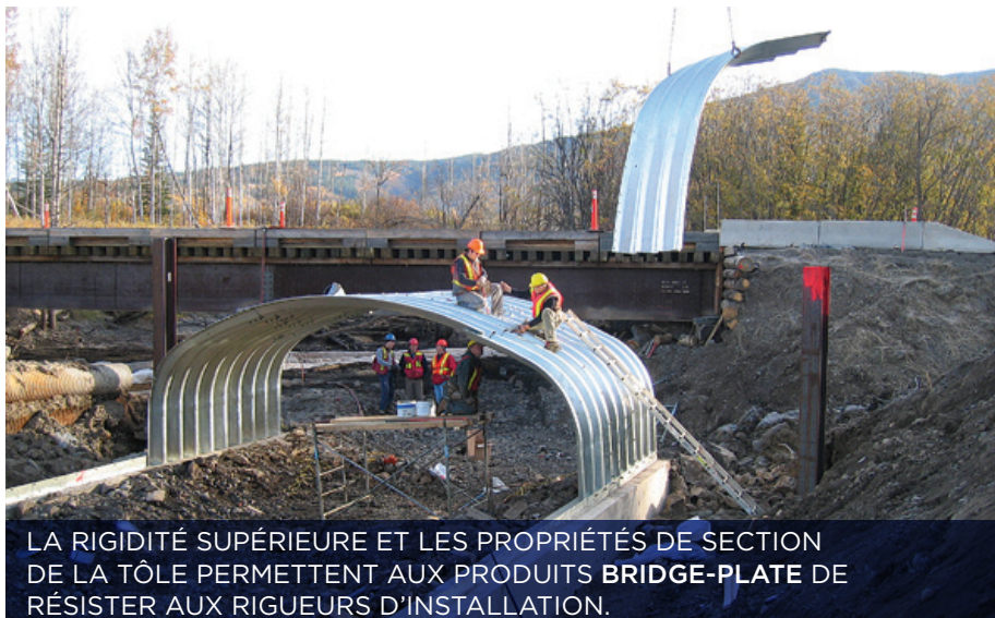
INSTALLATION D'UN BRIDGE-PLATE INCURVÉE
