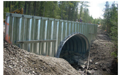
MUR DE TÊTE EN PALPLANCHES ARMTEC
