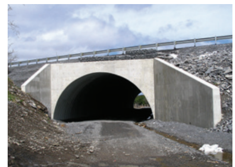
AUTOROUTE 401 À KINGSTON (ONTARIO) – INSTALLATION RAPIDE RÉDUISANT LA PERTURBATION POUR LES UTILISATEURS ROUTIERS
