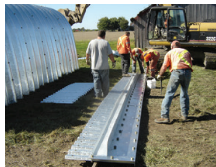
PONCEAU RECTANGULAIRE AVEC SEMELLES D'ACIER
