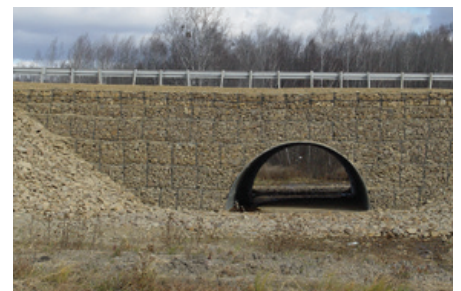
MURS DE TÊTE EN GABIONS
