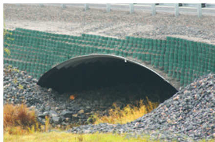
MURS DE SOUTÈNEMENT DE SOL STABILISÉ MÉCANIQUEMENT EN GÉOCELLULES
