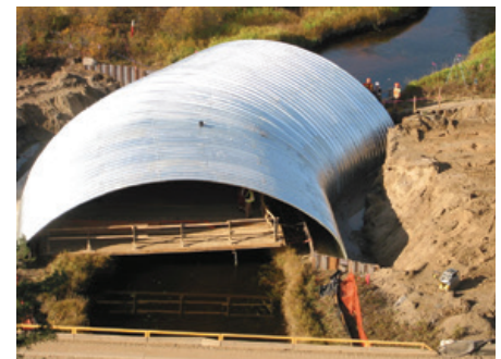
INSTALLATION D'UN BRIDGE-PLATE INCURVÉE
