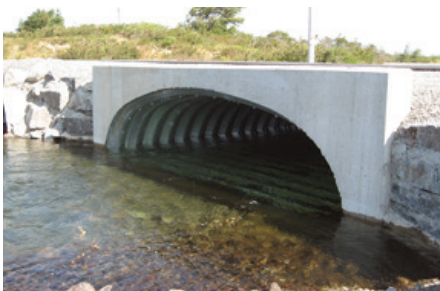
MURS DE TÊTE EN BÉTON COULÉ SUR PLACE
