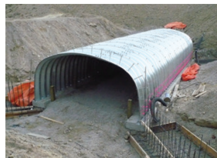
PONCEAU RECTANGULAIRE AVEC SEMELLES PRÉFABRIQUÉES
