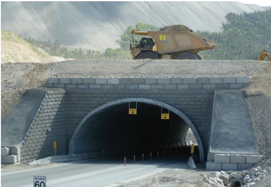
MURS D'EXTRÉMITÉ EN BLOCS SEGMENTAIRES
