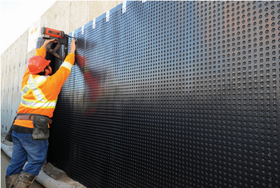
INSTALLATION DE SPEEDCLIPS TOUS LES 30CM (12")
