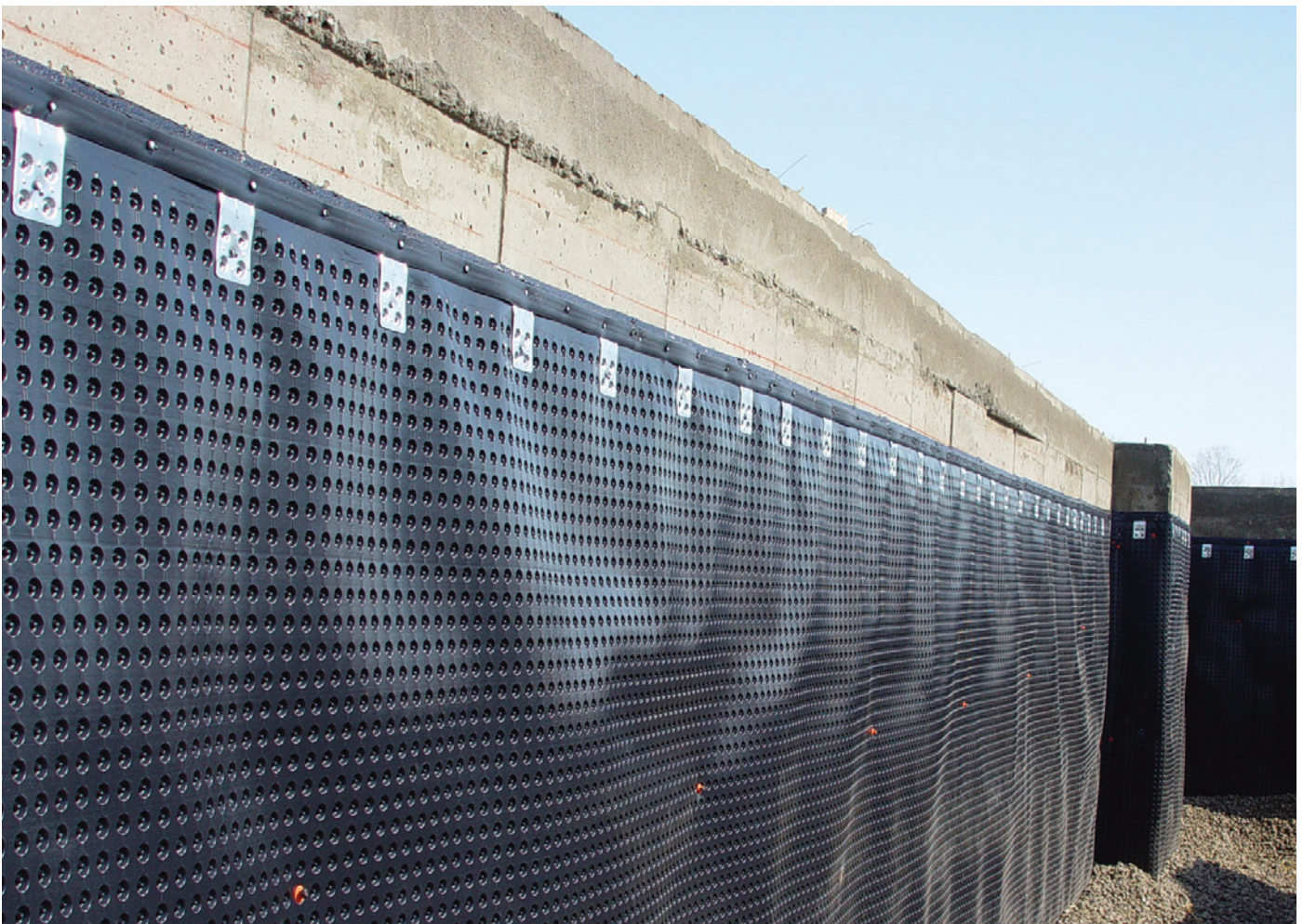
INSTALLATION FINIE DU PROTECTEUR DE FONDATION PLATON
