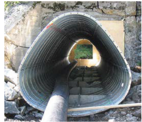
PRÉMONTAGE DES TÔLES DE REVÊTEMENT DE TUNNEL.
