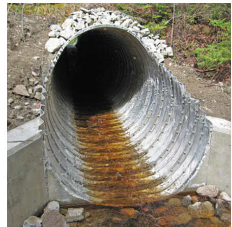
LE FAIBLE POIDS DES TÔLES DE REVÊTEMENT DE TUNNEL A PERMIS DE LES TRANSPORTER FACILEMENT DANS CET EMPLACEMENT RESTREINT DU PARC NATIONAL TERRA NOVA.
