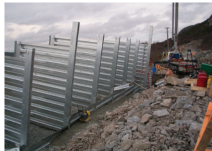
LES MURS-CAISSONS PEUVENT ÊTRE BOULONNÉS SUR PLACE OU LIVRÉS PRÉASSEMBLÉS SUR LE CHANTIER.
