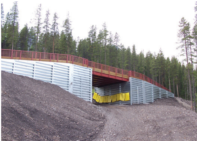
LA FAÇADE EN BOIS DONNE UNE APPARENCE NATURELLE À CETTE CULÉE DE PONT EN MURS-CAISSONS.
