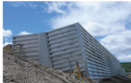
LE MUR-CAISSON INCLINÉ S'AJUSTE MIEUX AUX MOUVEMENTS MINEURS DU SOL.
