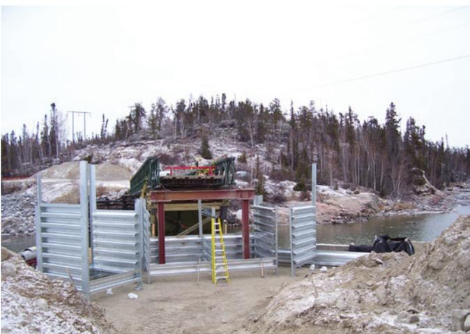
LES COMPOSANTES DES MURS-CAISSONS PEUVENT ÊTRE FACILEMENT BOULONNÉES ENSEMBLE POUR CRÉER DIVERSES CONFIGURATIONS
