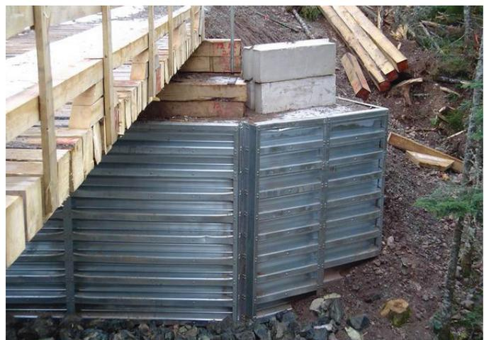
LES MURS-CAISSONS SONT FABRIQUÉS AVEC DES COMPOSANTES EN ACIER GALVANISÉ DURABLE
