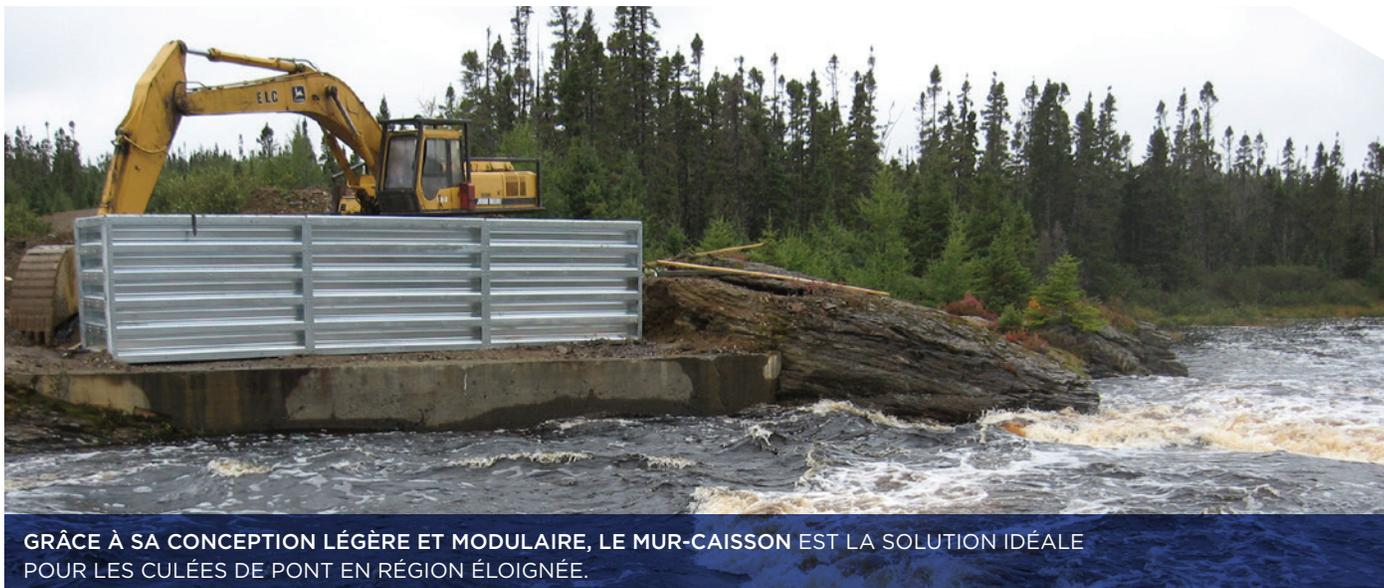
GRÂCE À SA CONCEPTION LÉGÈRE ET MODULAIRE, LE MUR-CAISSON EST LA SOLUTION IDÉALE POUR LES CULÉES DE PONT EN RÉGION ÉLOIGNÉE.
